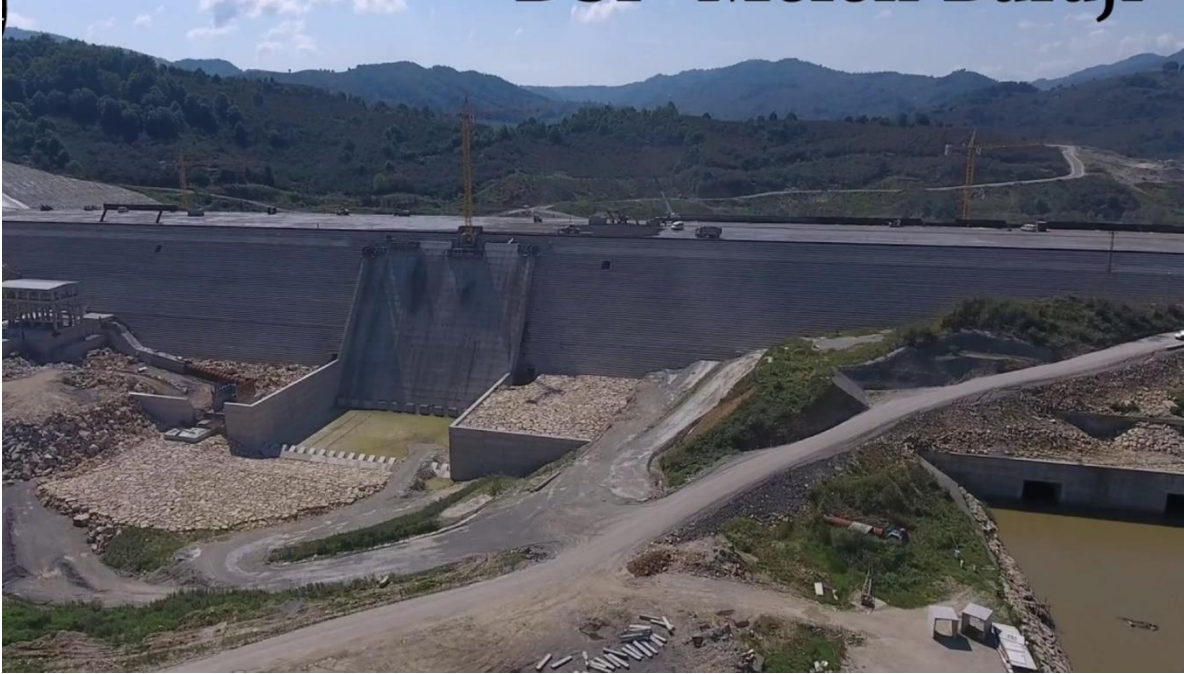
Melen Barajı'nın İnşaat Aşaması
