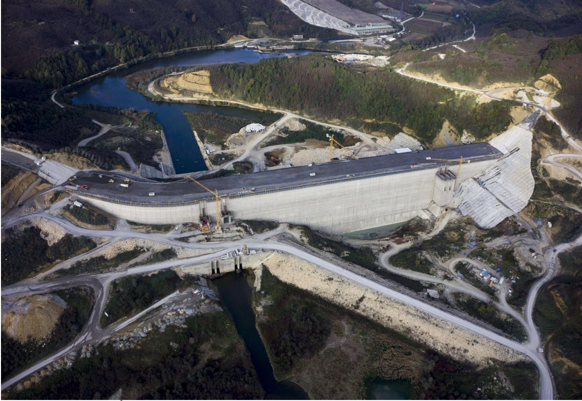
Melen Barajı'nın İnşaat Aşaması
