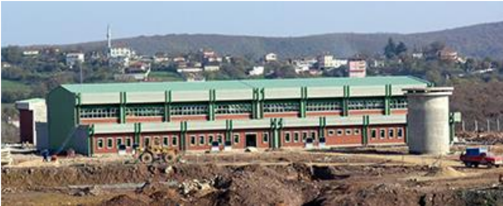
Melen Terfi Merkezi (Pompa İstasyonu)
